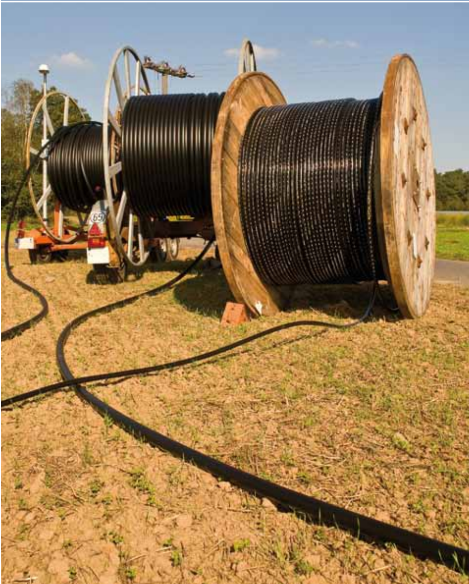
Układanie kabli / Cable laying
