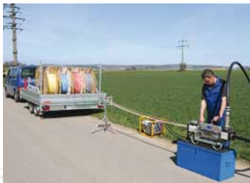
Wdmuchiwanie mikrokanalizacji / Blowing-in of microducts
