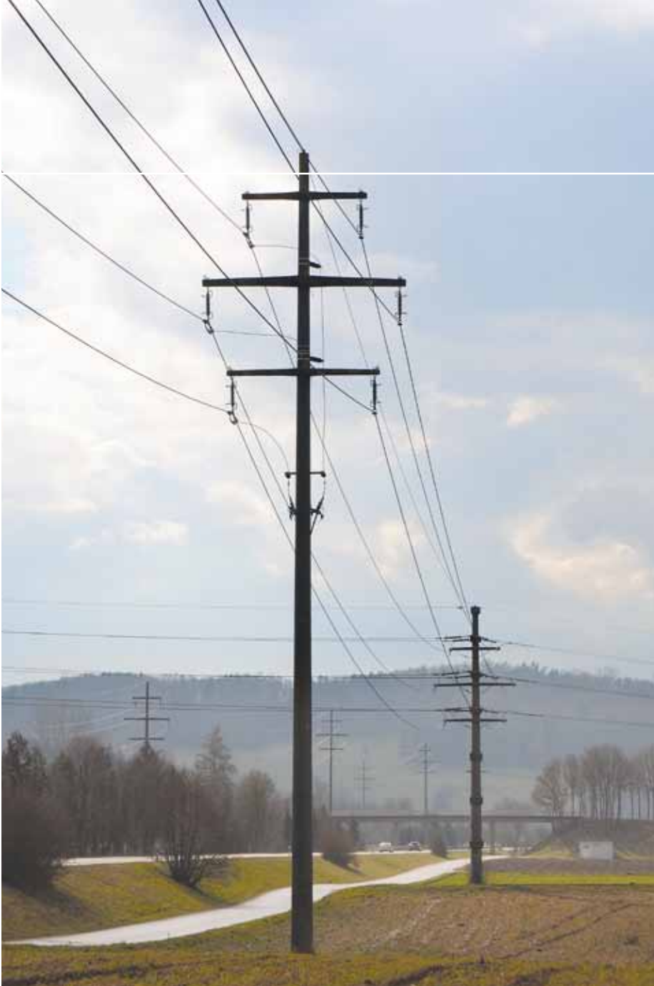
Napowietrzne linie energetyczne / Overhead line construction
