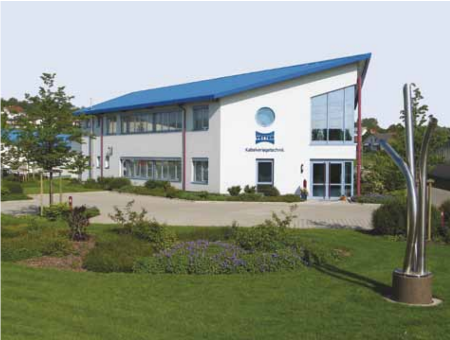
Siedziba firmy w Lottstetten / Premises in Lottstetten
